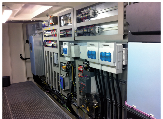
STEUERN UND VERSORGEN: Die modern ausgestattete Steuerkabine enthält den Steuerstand und einen Teil der Automatisierungstechnik. Bedienkabine und Elektorraum sind völlig unabhängig voneinander voll klimatisiert.
