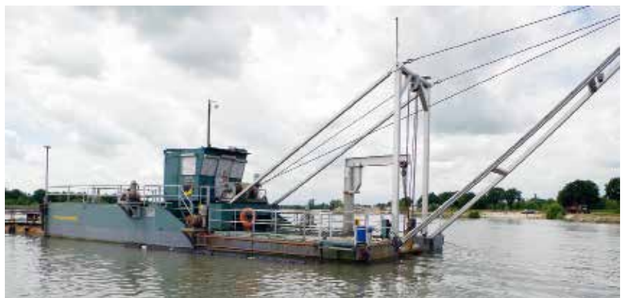
MACHBAR: Die meisten der in Betrieb stehenden Bestands-Saugbagger können mit den von Team gebotenen Automatisierungslösungen optimiert werden. Foto: bwi
